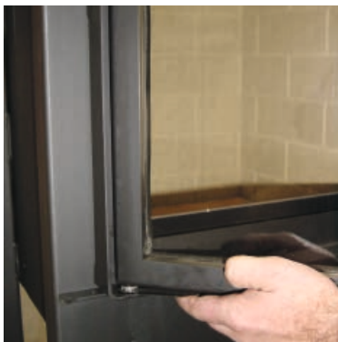
2. Spannschlüssel an den Scharnerring ansetzen und Scharnerring damit leicht zum Kamineinsatz drücken (Verkantung lockern)
