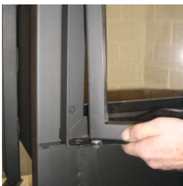
4. Türflügel schräg zum Körper und nach unten ziehen, bis sich der Türflügel vom oberen Bolzen im Zargenrahmen löst
