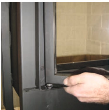
3. Türflügel zusammen mit dem Spannschlüssel nach oben drücken, bis der Bolzen aus der unteren Öffnung im Zargenrahmen austritt
