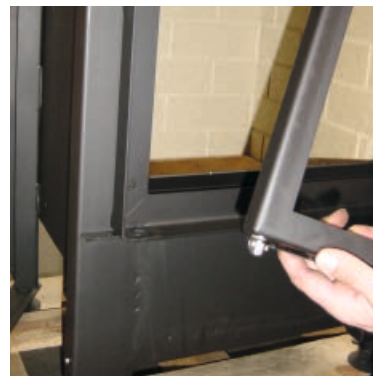
6. Spannschlüssel ca. 180° zum Türflügel (nach rechts – bei Linksanschlag) drehen, festhalten und Türflügel in umgekehrter Reihenfolge wieder einhängen
